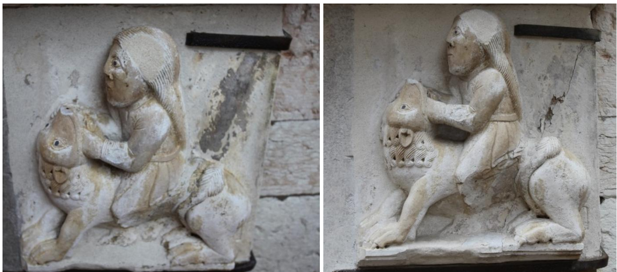
Figura 6.2: Fotografie della formella angolare di "Sansone che smascella il leone" prima e dopo l'evento sismico che ne ha causato il danneggiamento.
