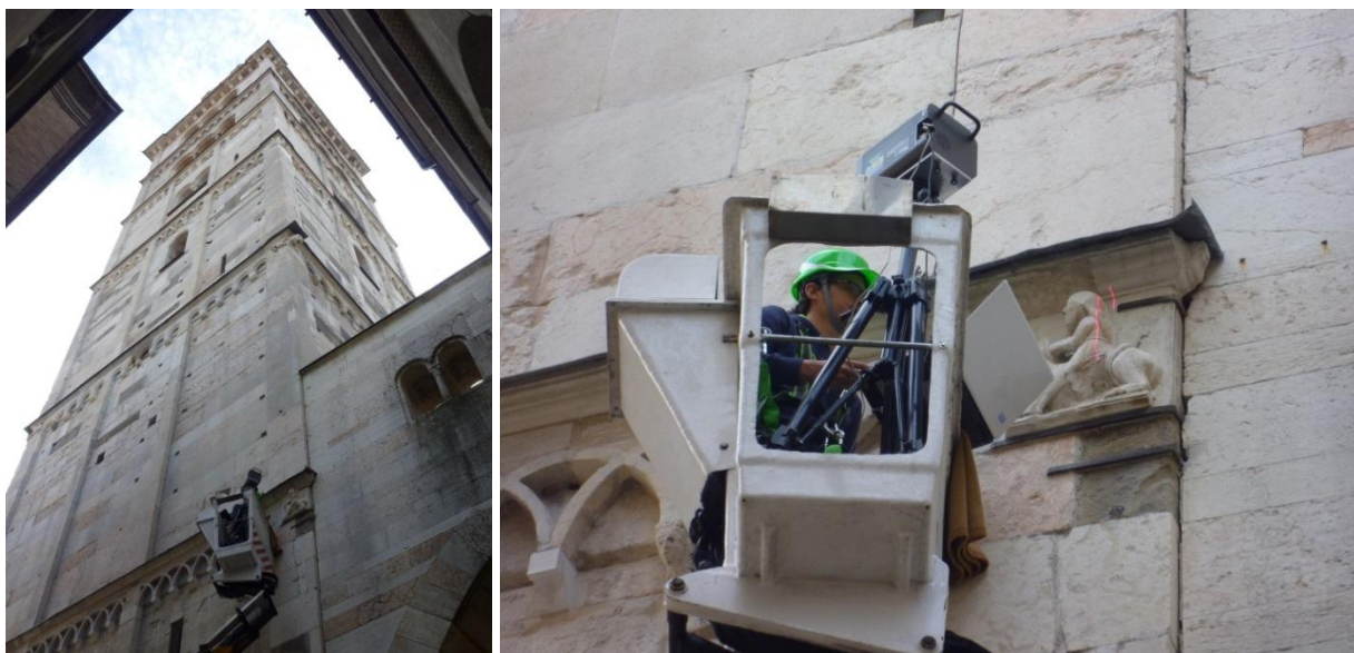
Figura 6.6: Fasi del rilevamento con laser scanner a triangolazione Range7 di Konica Minolta per la quantificazione del danneggiamento subito dalla formella angolare, Maggio 2014.
