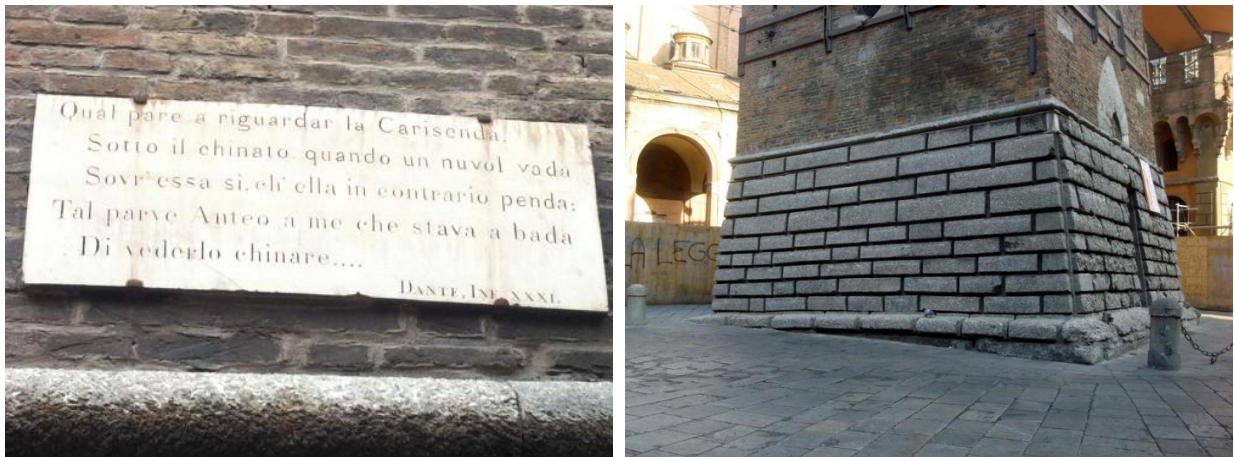
Figura 5.3: A sinistra, iscrizione sul lato Est in cui Dante ricorda la torre Garisenda nel canto XXXI dell'Inferno della Divina Commedia (vv. 136–141). A destra, fascia di ricoprimento selenitico alla base della struttura.
