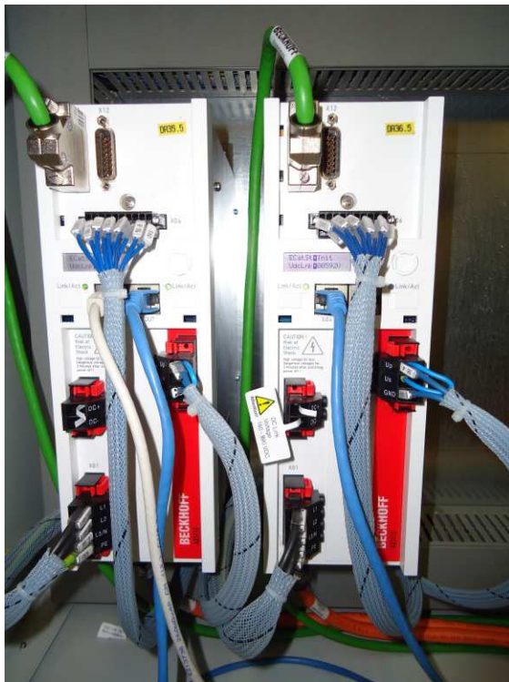
Figura 5.19: Drive BeckHoff presenti nel laboratorio LaPIS
