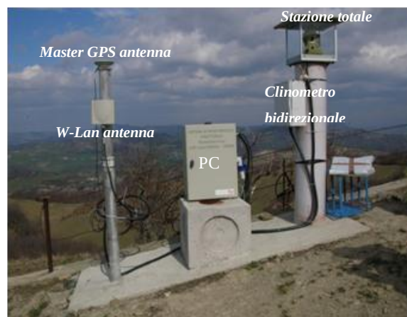
Figura 4.25: Master area (Are Vecchie). Da sinistra: antenna GNSS con antenna W-LAN, apparati di controllo, clinometro bi-direzionale e stazione totale.
