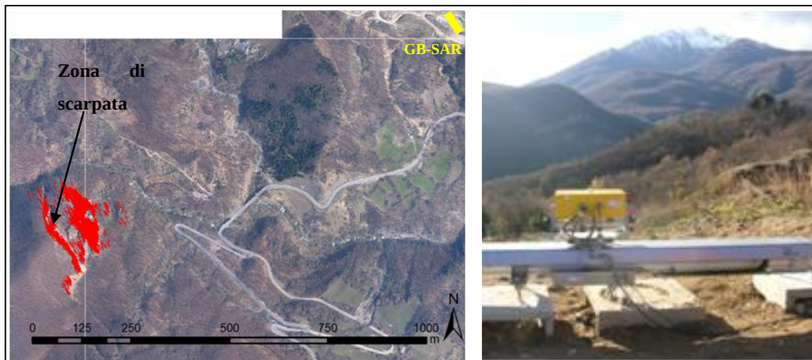
Figura 3.38: Mappa di coerenza dell'area selezionata [0.9, 1] georeferenziata e foto frontale del versante in basso a destra (Frana di Collagna, RE, Italia).
