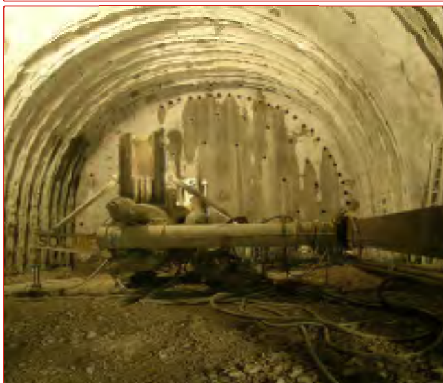
Rinforzo strutturale dell'opera sotterranea con l'utilizzo di fibre di carbonio specializzate.
