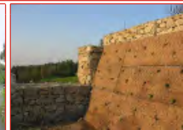
Opera di sostegno : Terramesh
