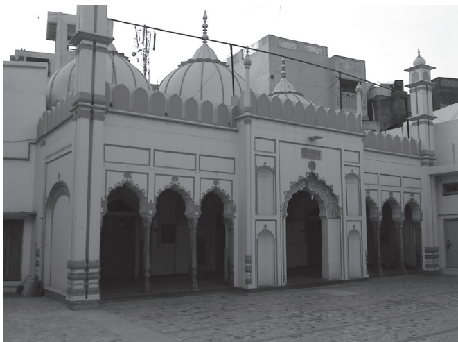
Fig.2: La moschea nel cortile interno della ḥānqāh .
