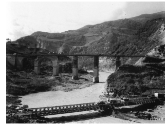
Genieri ricostruiscono il ponte di Valsalva sul Santerno. In basso, il traffico militare attraversa un ponte di fortuna (IBC Combat photo)
