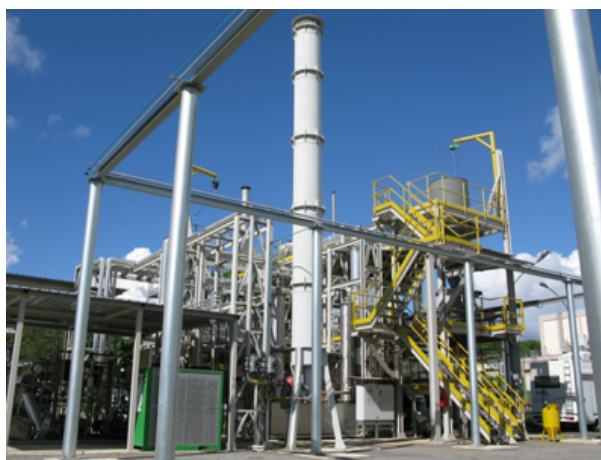
Reattore di "Calcium Looping", cuore della Infrastruttura di Ricerca ZECOMIX
