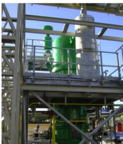
Reattore di "Calcium Looping", cuore della Infrastruttura di Ricerca ZECOMIX
